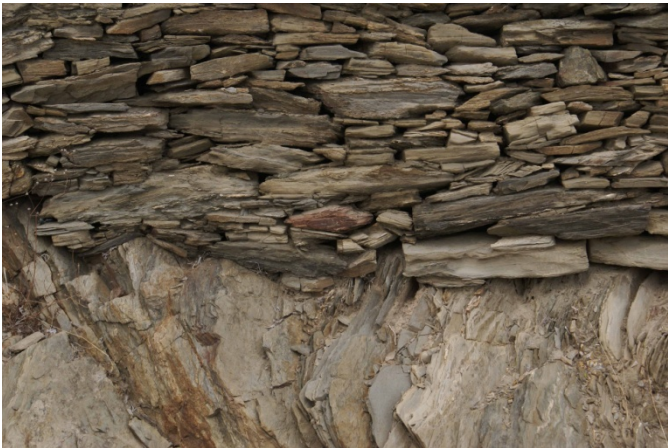
Figura 5 Detalle muro en Piedra seca.
