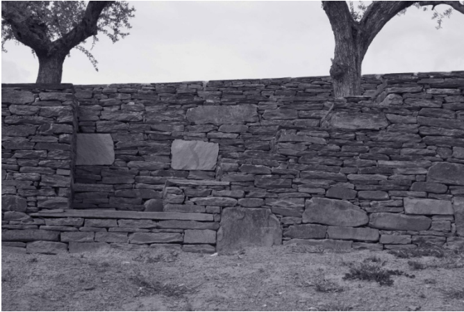
Figura 4 Escalera integrada en el espesor del muro.
